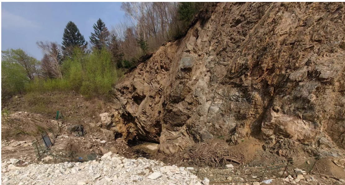
现场照片3-1 露天采场内边坡
