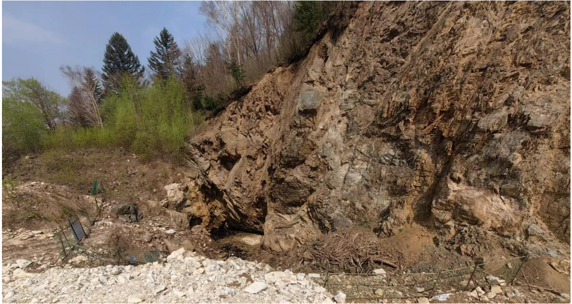
照片1-2 采场边坡照片
