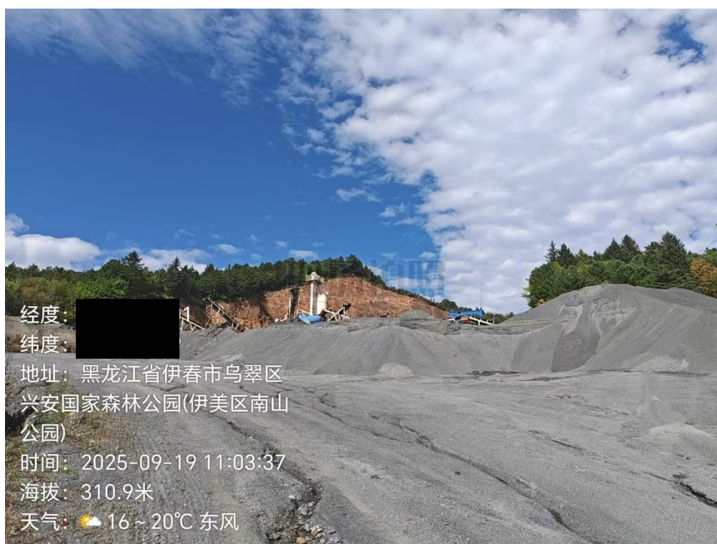
照片 3-3 矿区土地损毁（生态受损）照片
